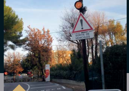
Installation d'aménagements sécuritaires (sortie de la zone d'activités des Bois de Grasse sur le Boulevard E. Rouquier). (1 er février)
